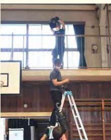
照明機材の設置
