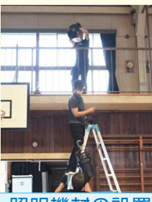
照明機材の設置
